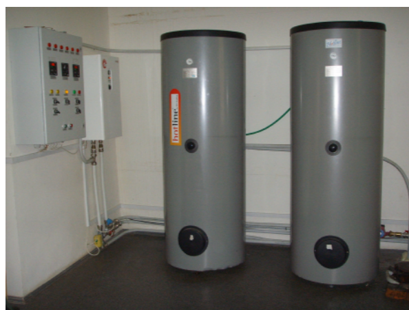
Рисунок 2.11 – Шкаф управления тепловым насосом БТА
