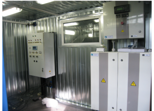
Рисунок 2.13 –Отсек управления мини-ТЭЦ
