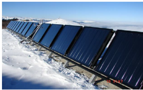
Рисунок 2.9 – Система солнечного теплоснабжения технического блока БТА
